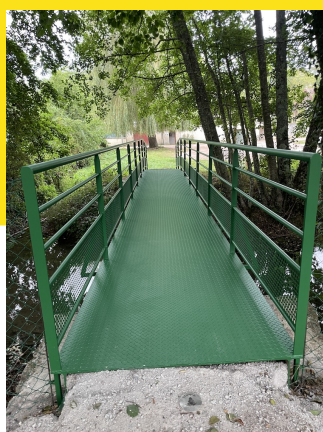
Passerelle reliant la zone humide au Placier de la Folie
