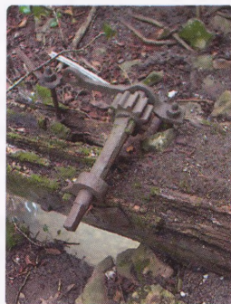
Vestige du mécanisme de manoeuvre des vannes
