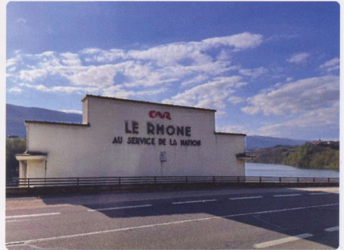
Barrage et usine hydro-électrique de Seyssel
