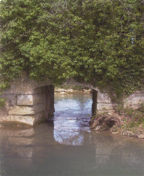
Vue amont du Louébré
